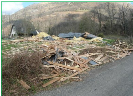
Toiture envolée à Bedous en 2010
