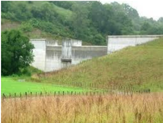
Barrage écrêteur des crues de la Nivelle (Saint-Pée-sur-Nivelle)
