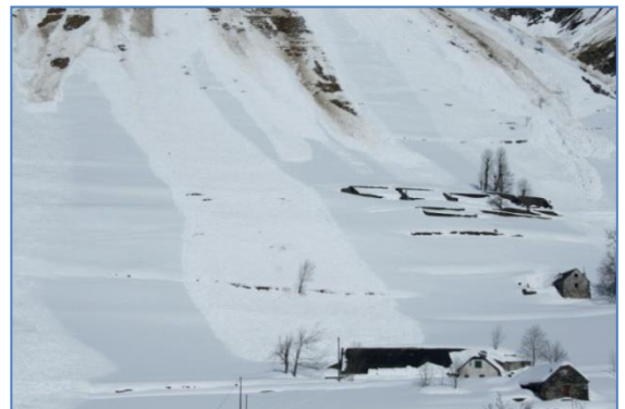
Des habitations menacées par des avalanches en février 2009
