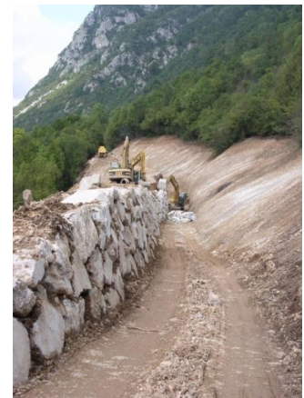
Merlon de protection à Aste-Béon
