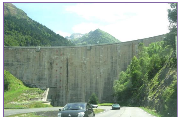
Barrage de Fabrèges
