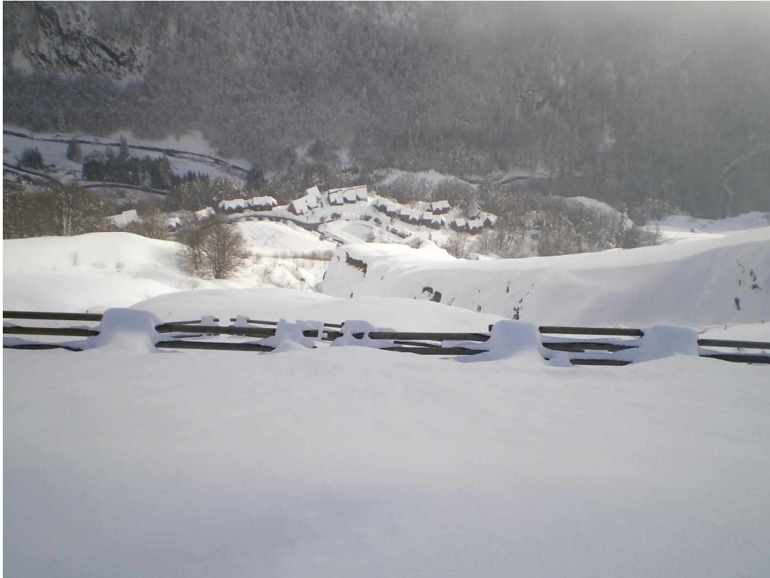
Illustration n°11 : Claiés bois -emprise n°4 - Couloir de Crêtes Blanches est, CLPA n°2 - Prise de vue le 13 février 2009 - G. Viprey, ONF-RTM
